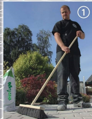
Das Material in die Fugen einfeigen
