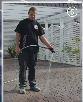
Verwenden Sie einen starken Wasserstrahl, um eventuelle Reste von Zuschlagstoffen von der Oberfläche abzuwaschen. Wiederholen Sie den Sprühvorgang mehrere Male.
