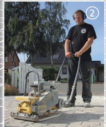
Beim Neubeleg gut verdichten
